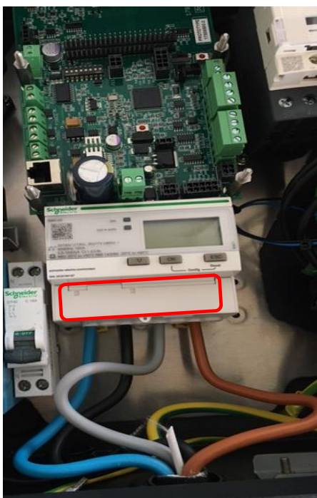
Figure 2. Photo du raccordement de l'alimentation dans la borne (cas particulier du compteur MID).
